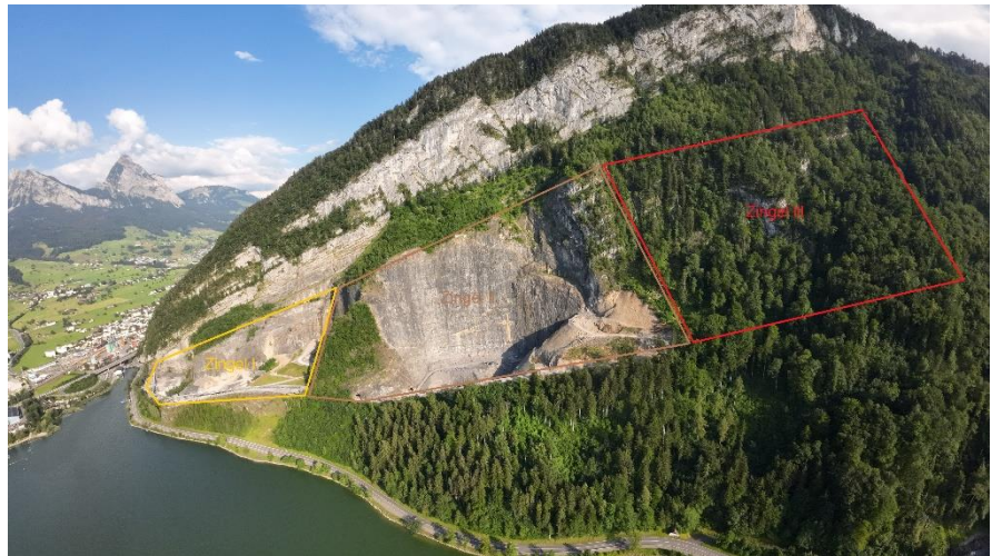
Foto von Kibag Kies Seewen AG; Erweiterungsbereich rot-markiert
